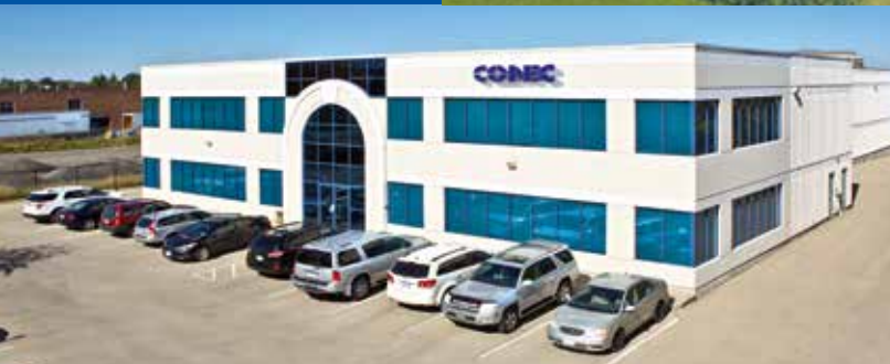
CONEC Canada, Brampton
